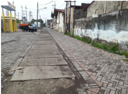
Pemasangan paving untuk jalan warga di kawasan Tritan Point Banyu Urip Surabaya seluas 280 m 2
